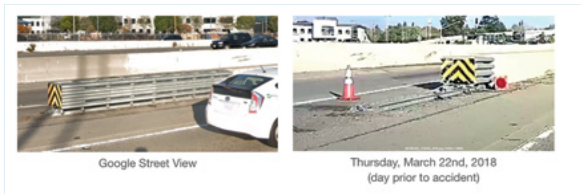
(c) Botsabsorber in normale situatie en een dag voor de fatale crash.
